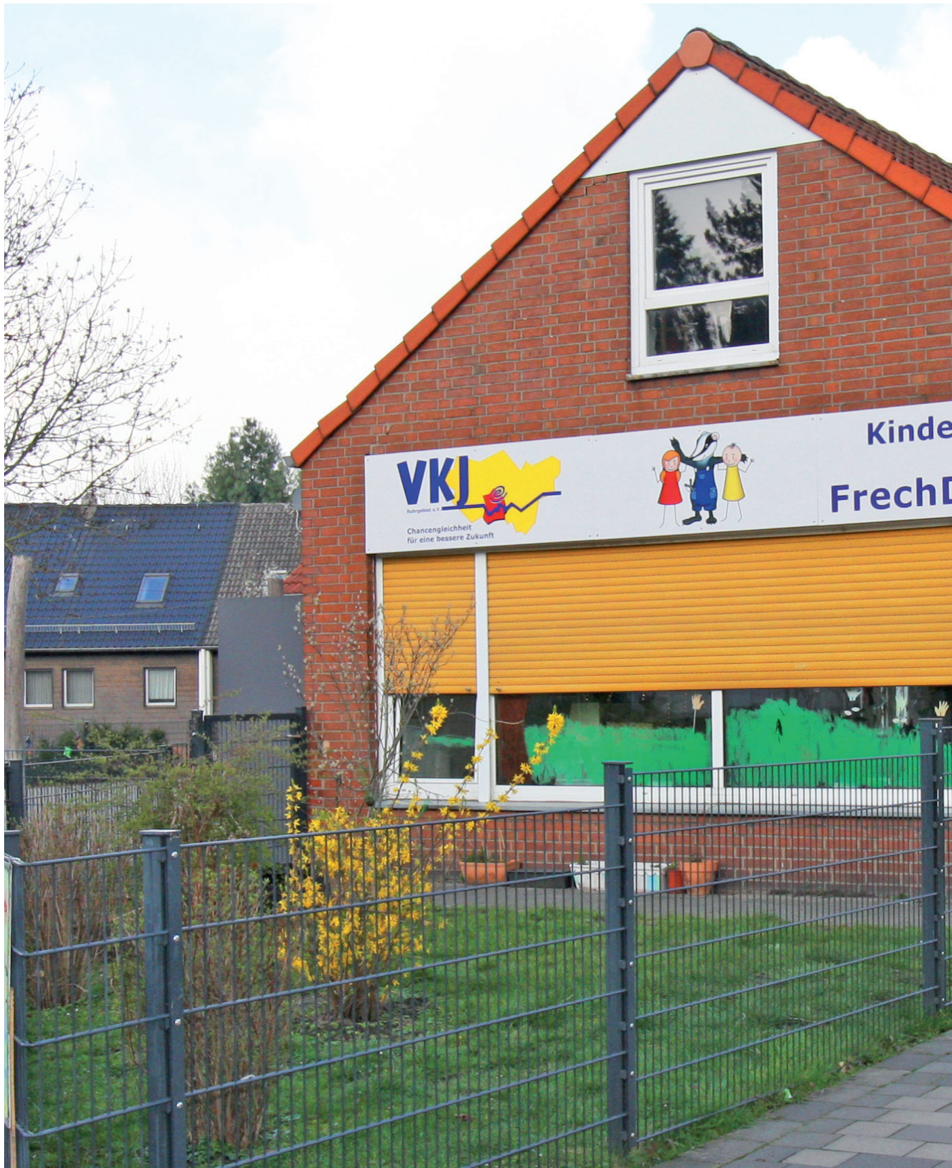
Das VKJ-Kinderhaus FrechDachse in Dellwig bietet viel Raum für die Kinder - auch ein großzügiges Außengelände gehört zum VKJ-Kinderhaus.
