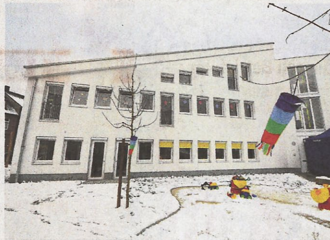
Die Form ist bekannt, die Fassade neu: die Kita „Windvogel“.
